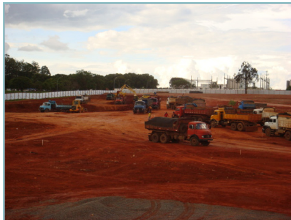
Foto 12 – Execução de Terraplenagem
