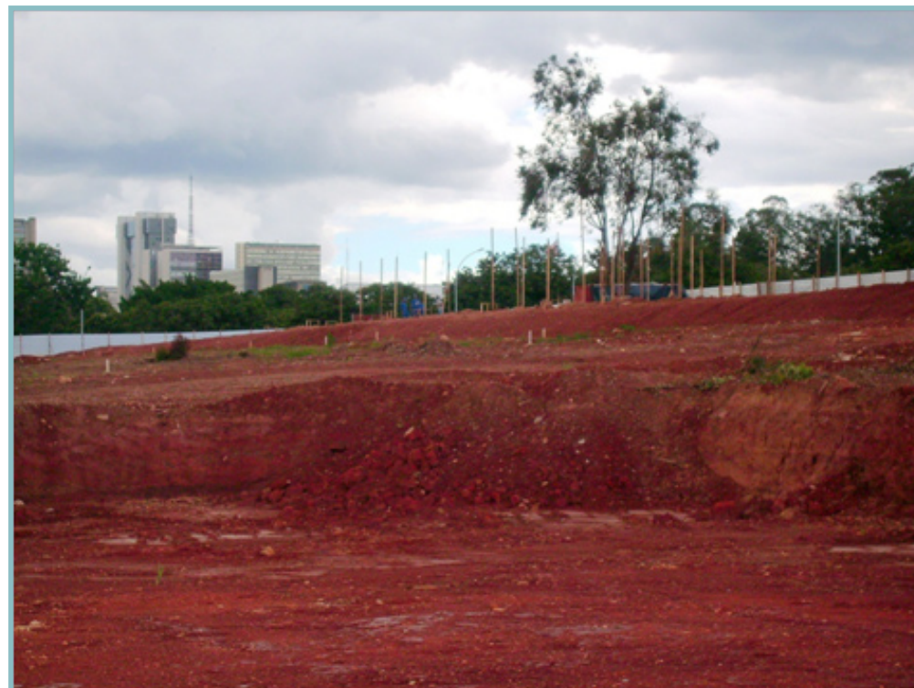
Foto 18 – Execução de Terraplenagem
