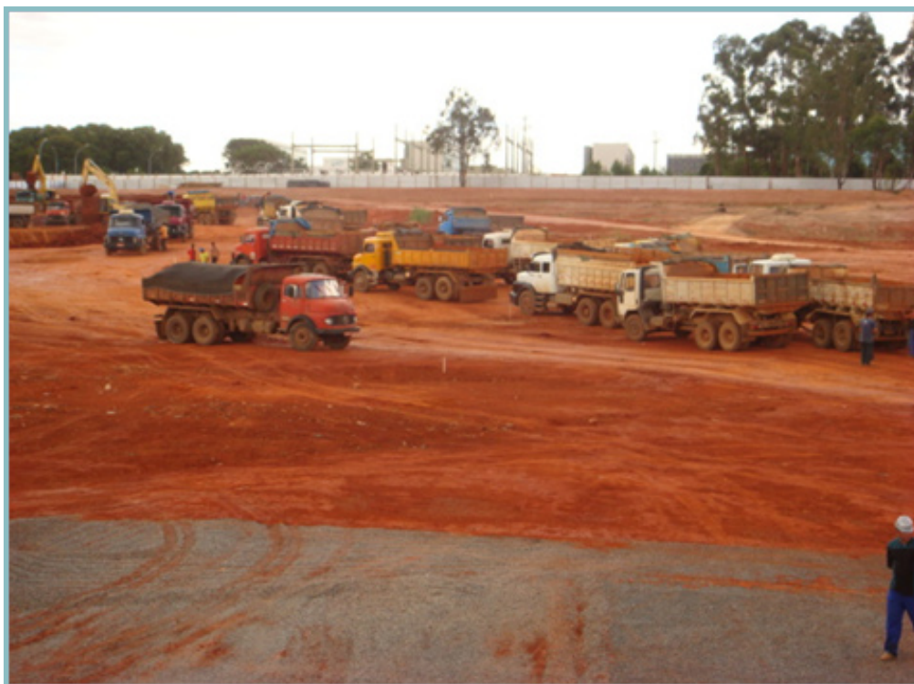
Foto 11 – Execução de Terraplenagem
