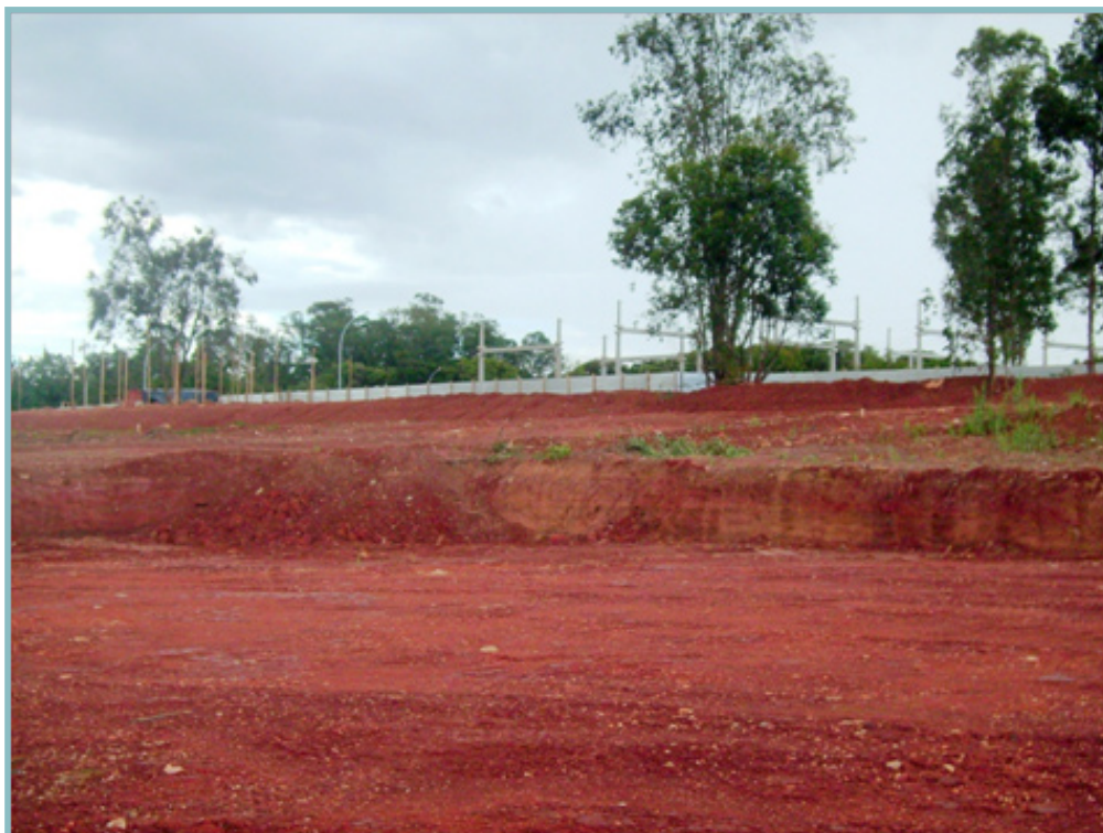
Foto 17 – Execução de Terraplenagem
