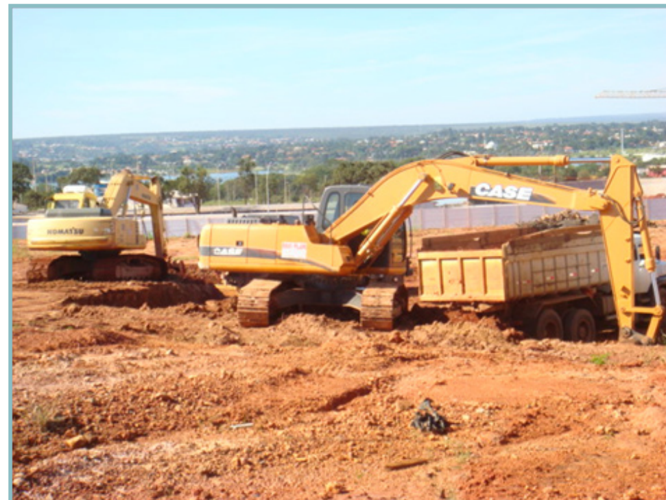
Foto 10 – Execução de Terraplenagem
