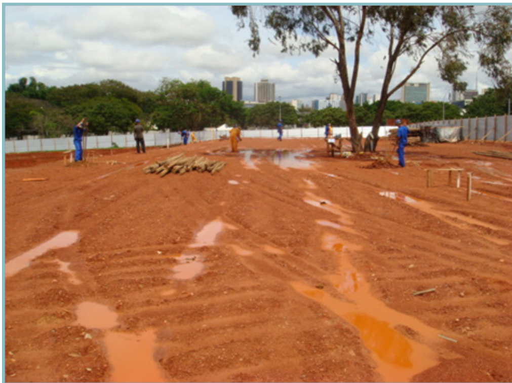
Foto 3 – Locação de obras
