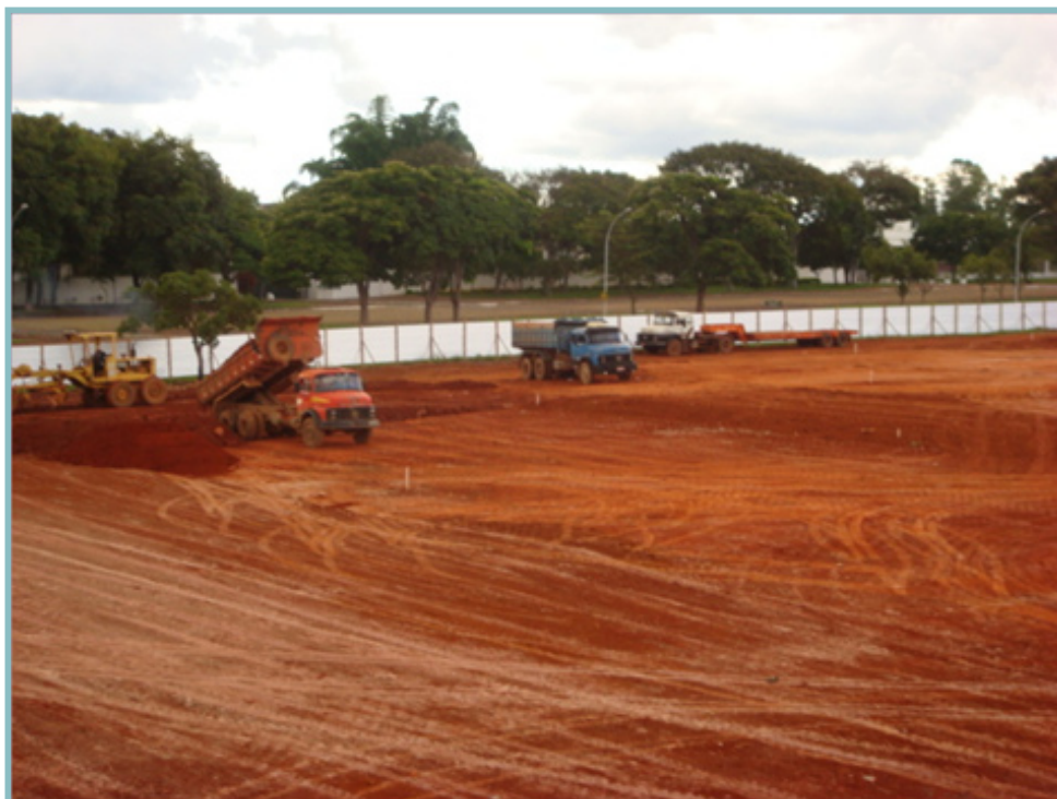
Foto 13 – Execução de Terraplenagem
