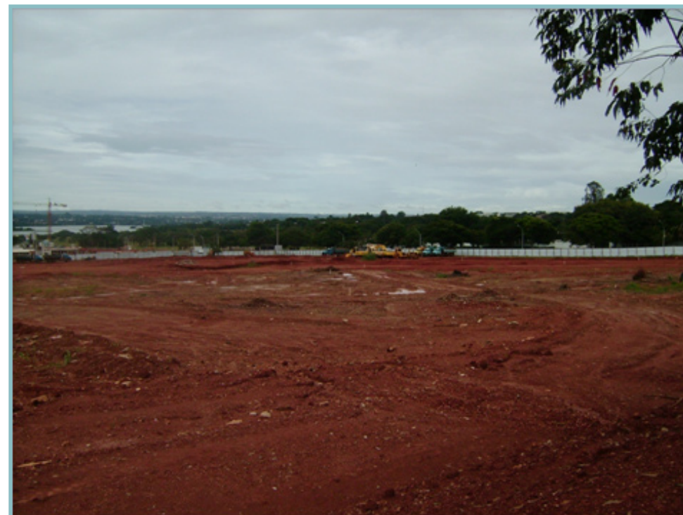
Foto 6 – limpeza e preparo da área para terraplenagem
