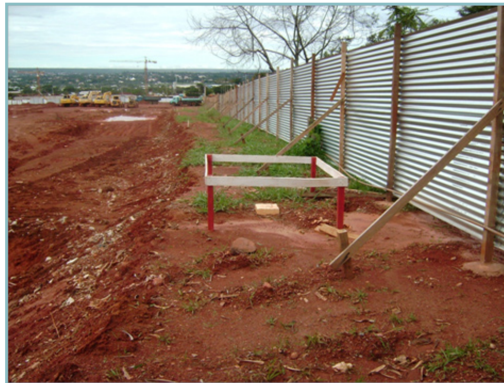
Foto 4 – Locação de obras
