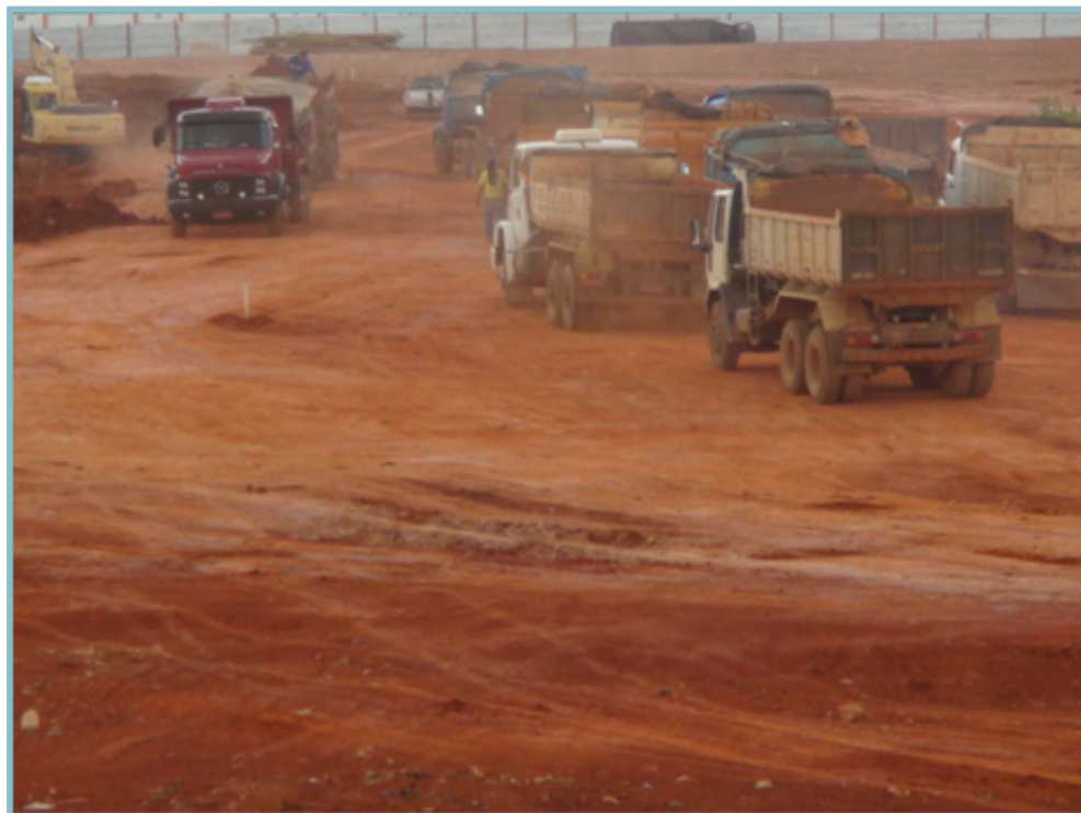
Foto 15 – Execução de Terraplenagem
