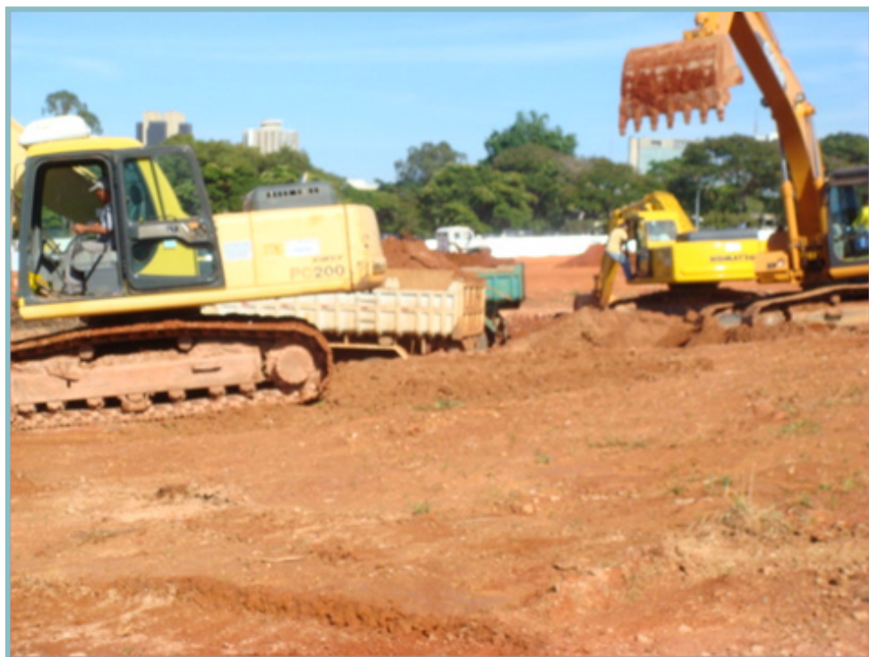
Foto 7 – Execução de Terraplenagem
