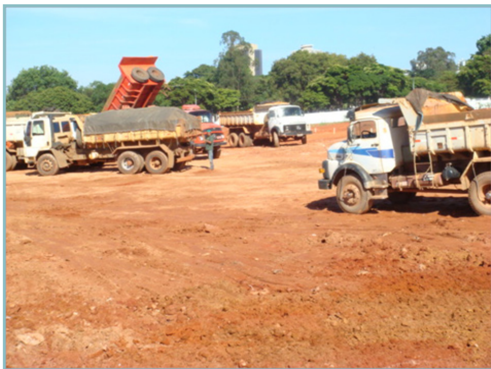
Foto 9 – Execução de Terraplenagem
