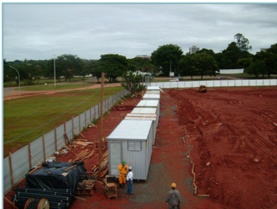
Foto 1 – Construções e Ligações Provisórias
