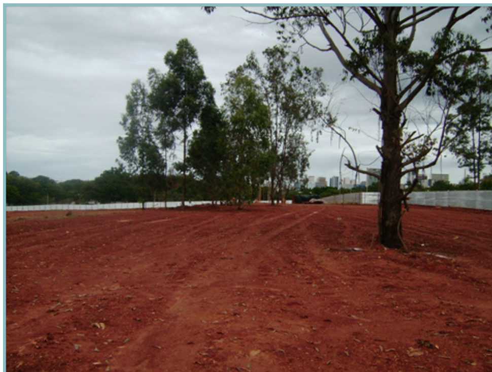
Foto 5 – limpeza e preparo da área para terraplenagem
