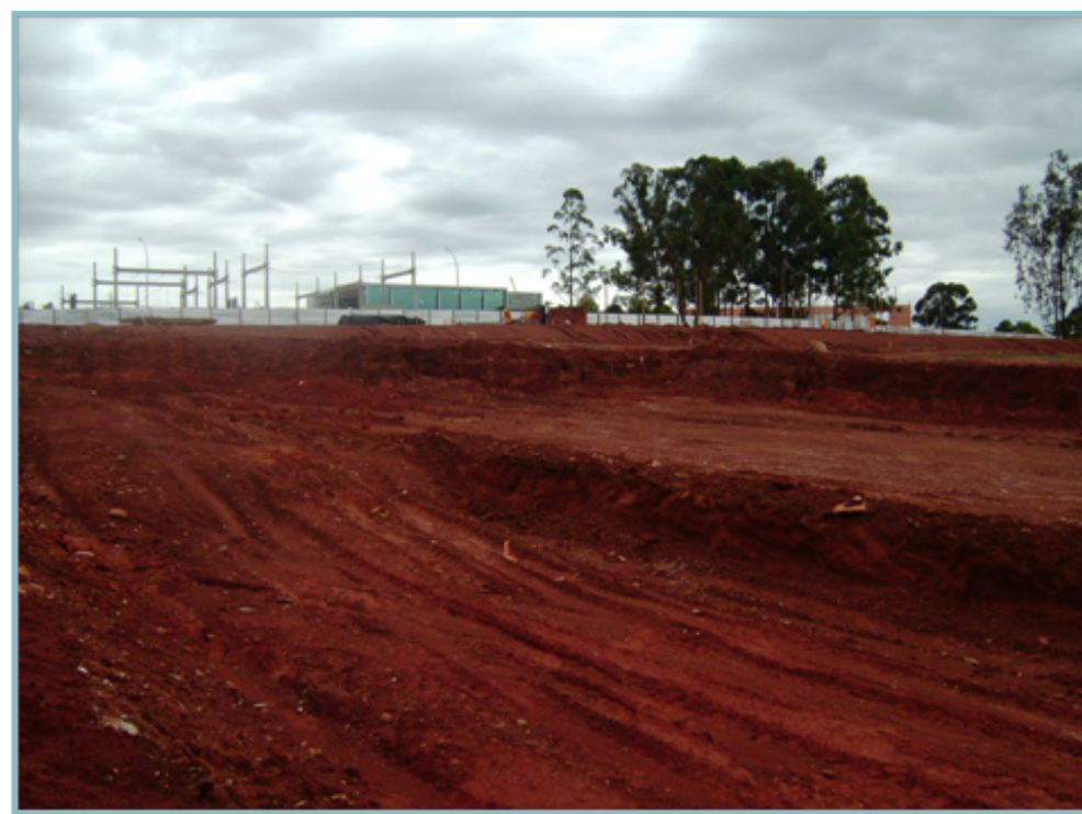
Foto 16 – Execução de Terraplenagem
