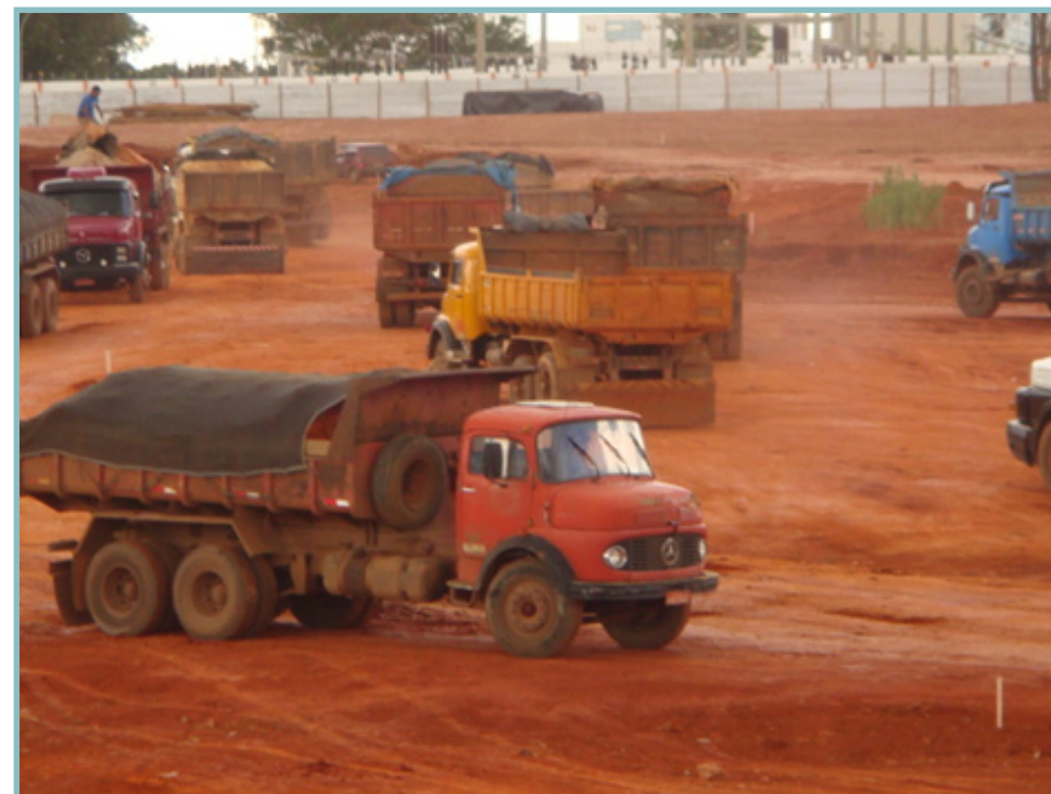
Foto 14 – Execução de Terraplenagem
