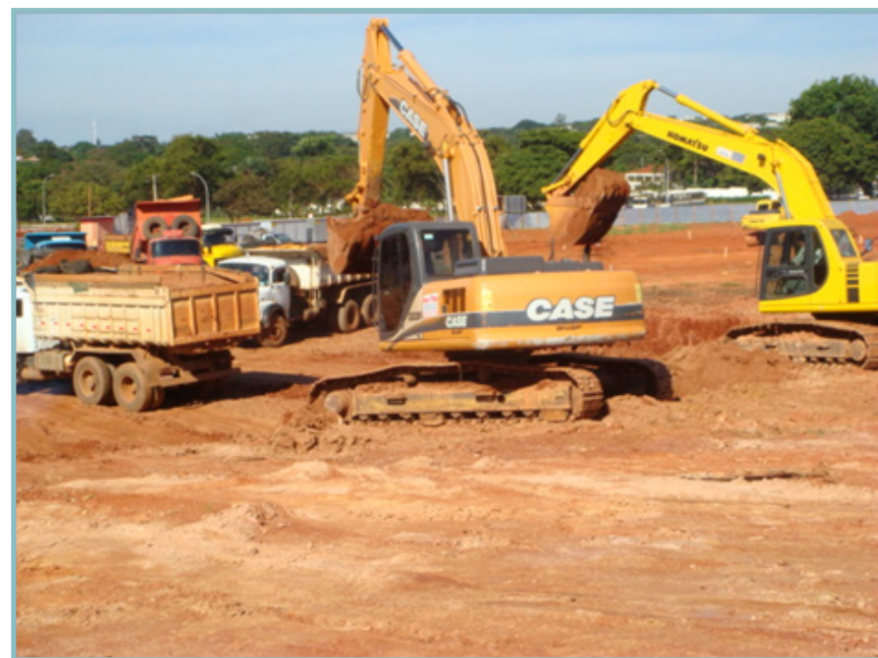
Foto 8 – Execução de Terraplenagem
