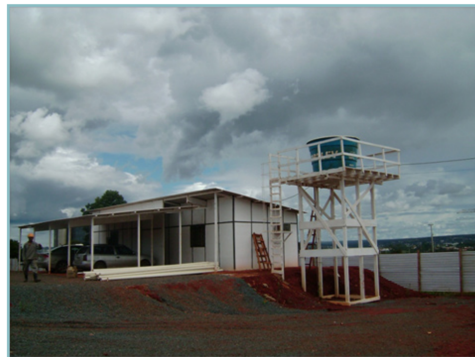
Foto 2 – Construções e Ligações Provisórias
